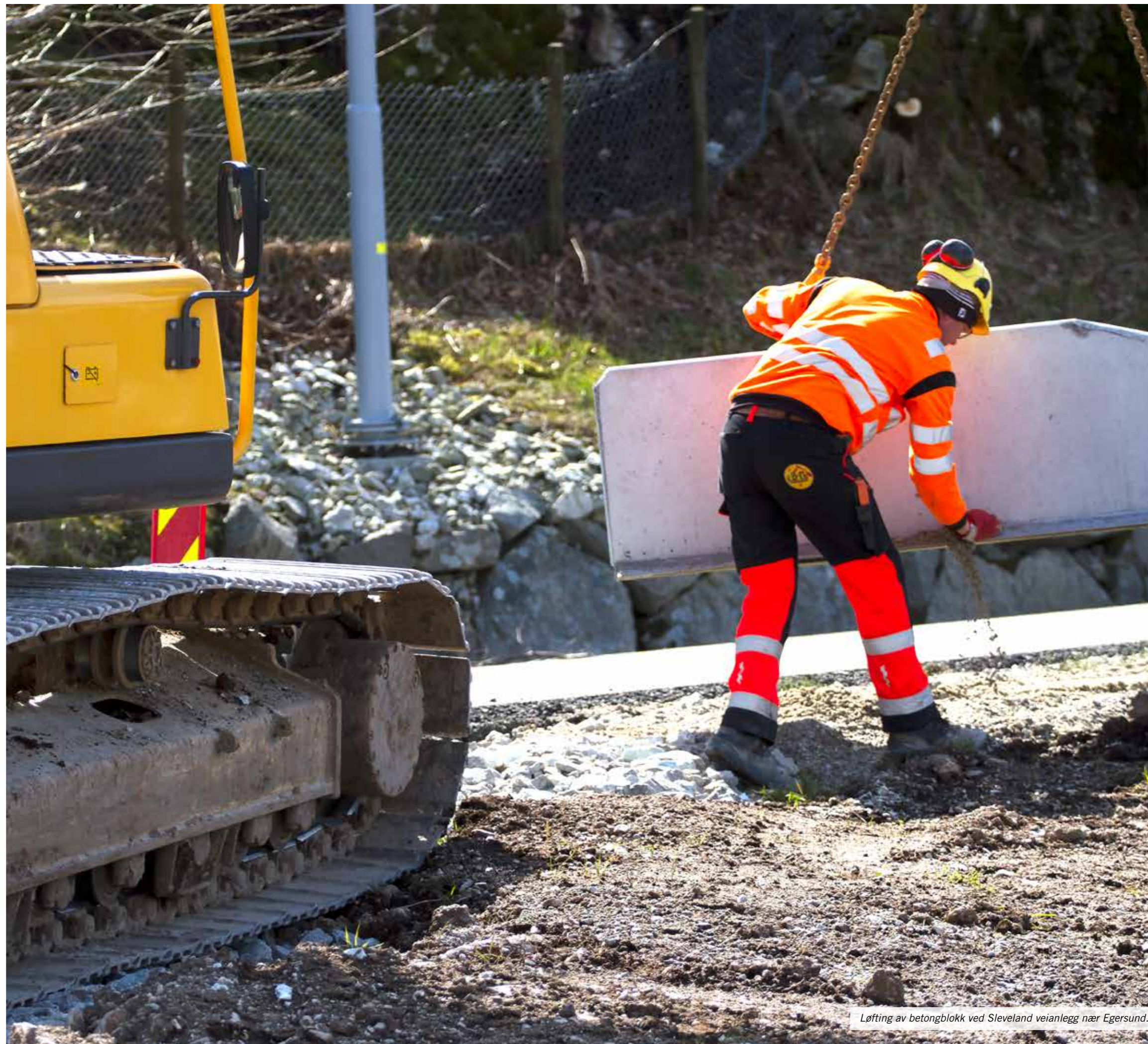
B&G bygget Lyseveien, fra Lysebotn til Sirdal. Den går gjennom 27 hårnålssvinger og er 29 km lang. Veien ble åpnet i 1984.
